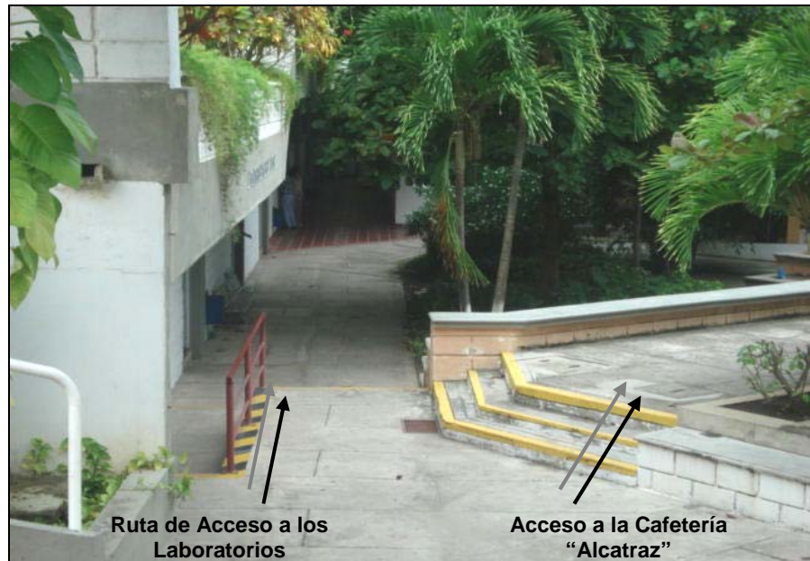
Figura 15a. Acceso a la Zona de Laboratorios- Primer Nivel Edificio Aulas 2
