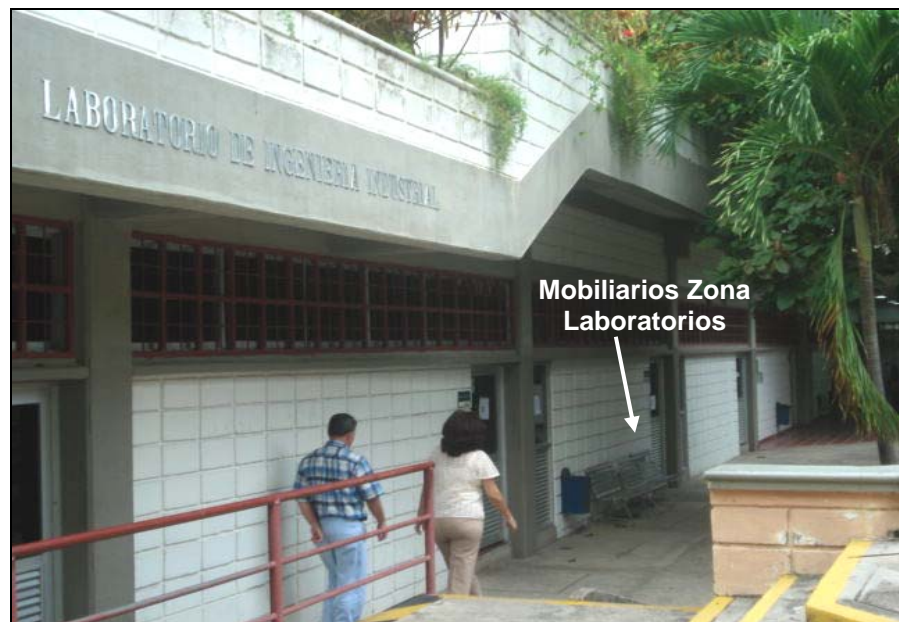
Figura 15b. Vista Frontal de los Laboratorios de Ingeniería Industrial
