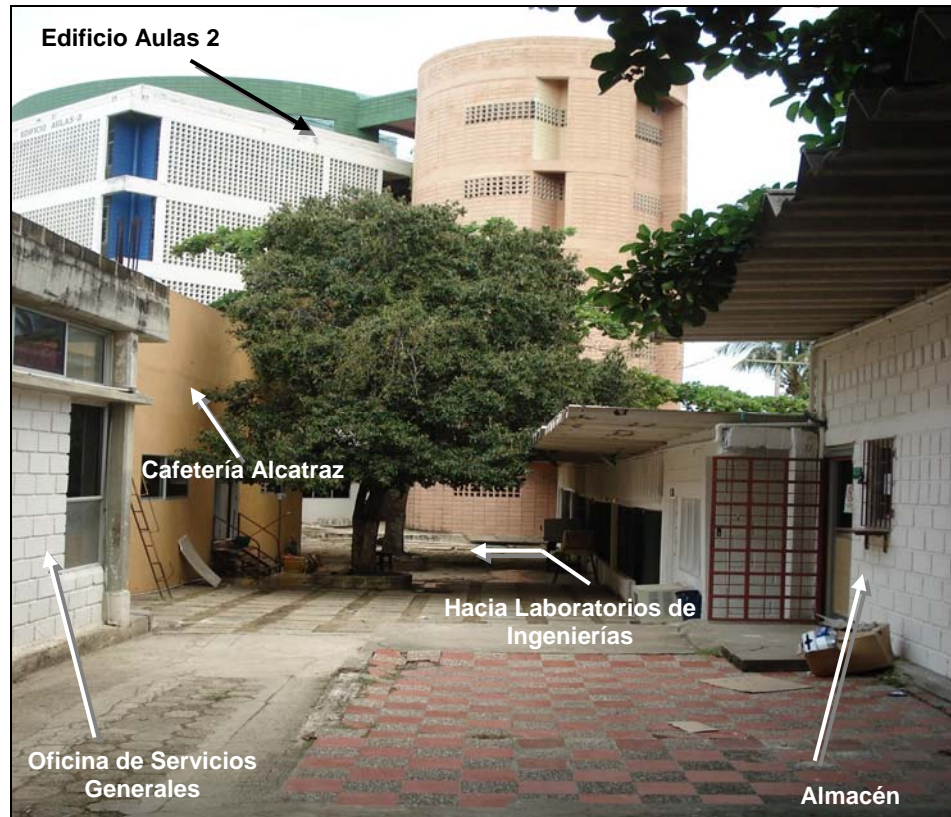
Figura 17. Zona de Mantenimiento y Servicios Generales
