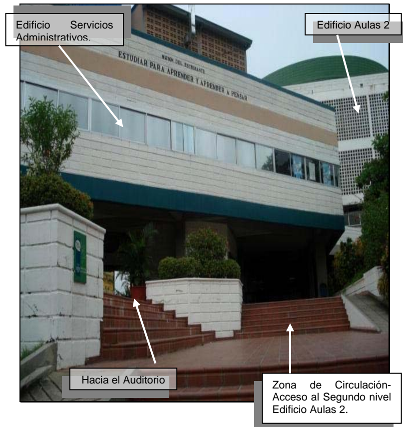
Figura 13a. Zona de Acceso- Edificio Aulas 2
