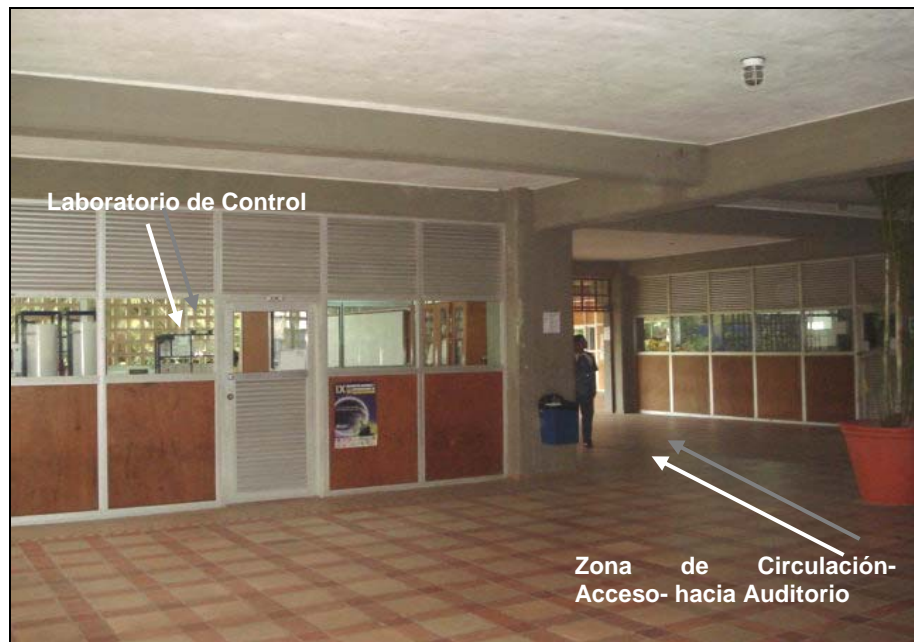
Figura 13b. Zona de Laboratorios Electrónica- Segundo Nivel Edificio Aulas 2
