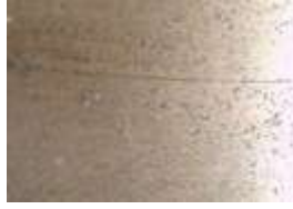
Figura 6-12. Corrosión en cojinetes Tomada de Widman International SRL
