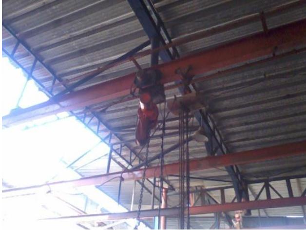
Imagen 26. Transporte interno, rieles.
