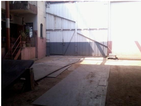
Imagen 18. Puerta de acceso de materiales.
