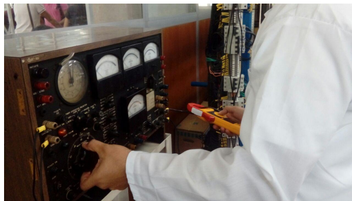
Figura. 53 Inyección de corriente.
