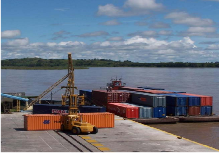
Ilustración 9. Operaciones de Descargue de contenedores en Puerto Fluvial
