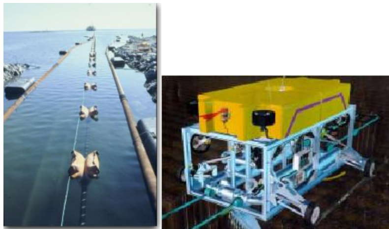
Figura 29 Cable submarino y robot que lo fija a la profundidad y la línea a seguir
