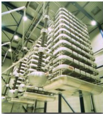
Figura 21. Convertidor de 12 pulsos
