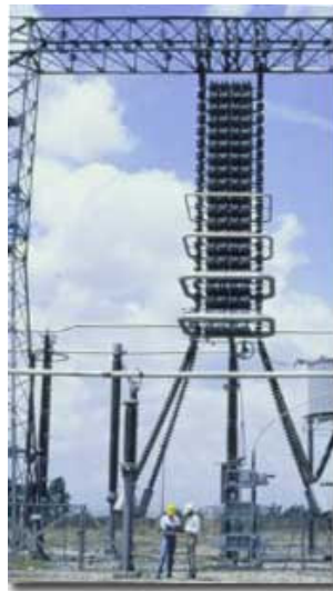
Figura 28. Capacitor de filtro suspendido de 500kV para áreas sísmicas
