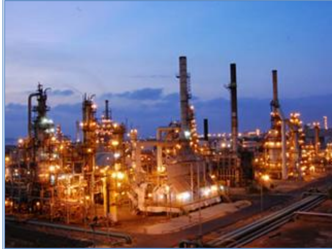
Ilustración 5 Refinería Ecopetrol. Cartagena. Fuente: Archivo Refinería de Cartagena
