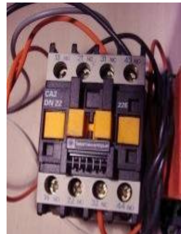
Figura 14. Símbolo del Contactor trifásico Figura 15. Imagen Contactor trifásico
