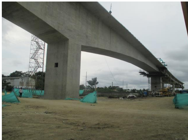
Foto 7: Construcción del nuevo puente
