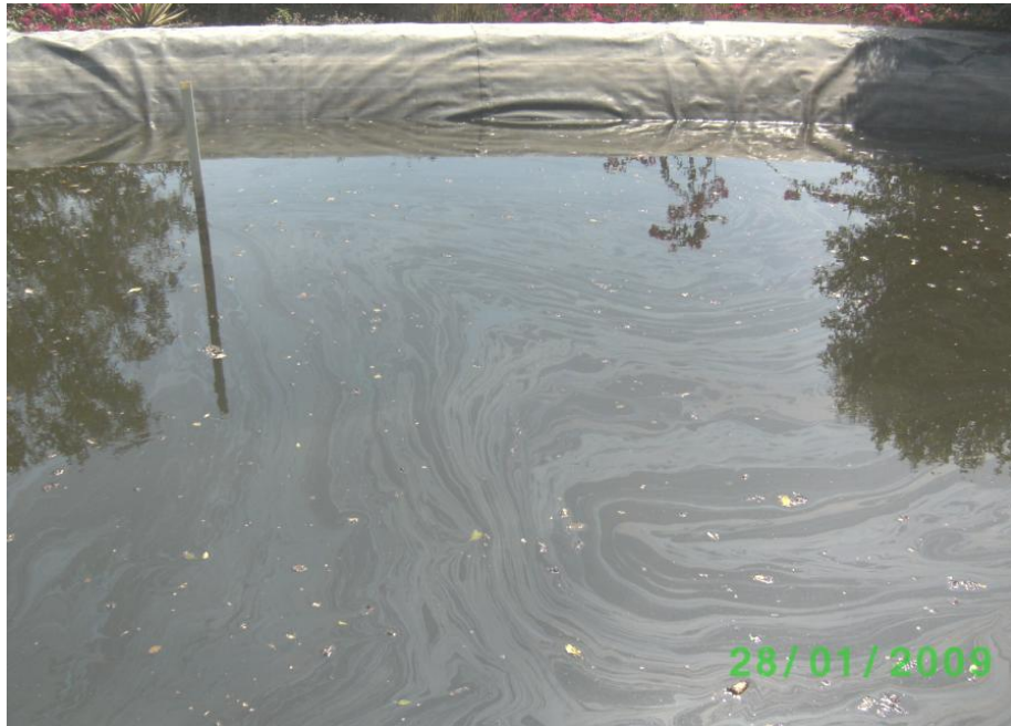
Pozo que recoge el líquido que posiblemente llega a los registros de las celdas de seguridad ( el pozo eta recubierto con una geomembrana (plástico negro) para evitar contaminación y el agua que se encuentra es de la lluvia)
