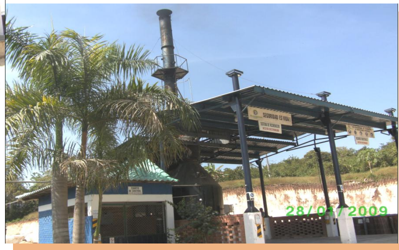
Chimenea del horno
