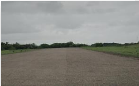
Ilustración 41 Pista de Aterrizaje
