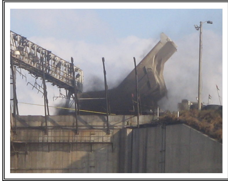
Figura7.2 Camión descargando en las tolvas
