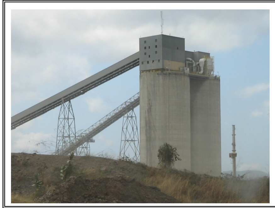
Figura 7.4 Silos para almacenamiento del carbón
