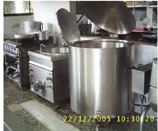
Foto 14. Cocina principal. Fuente: Autor del Proyecto
