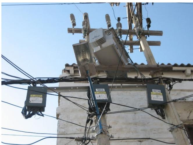
**Figura 11. Transformador T12 - Nodo Aéreo de Medida Centralizada.**
