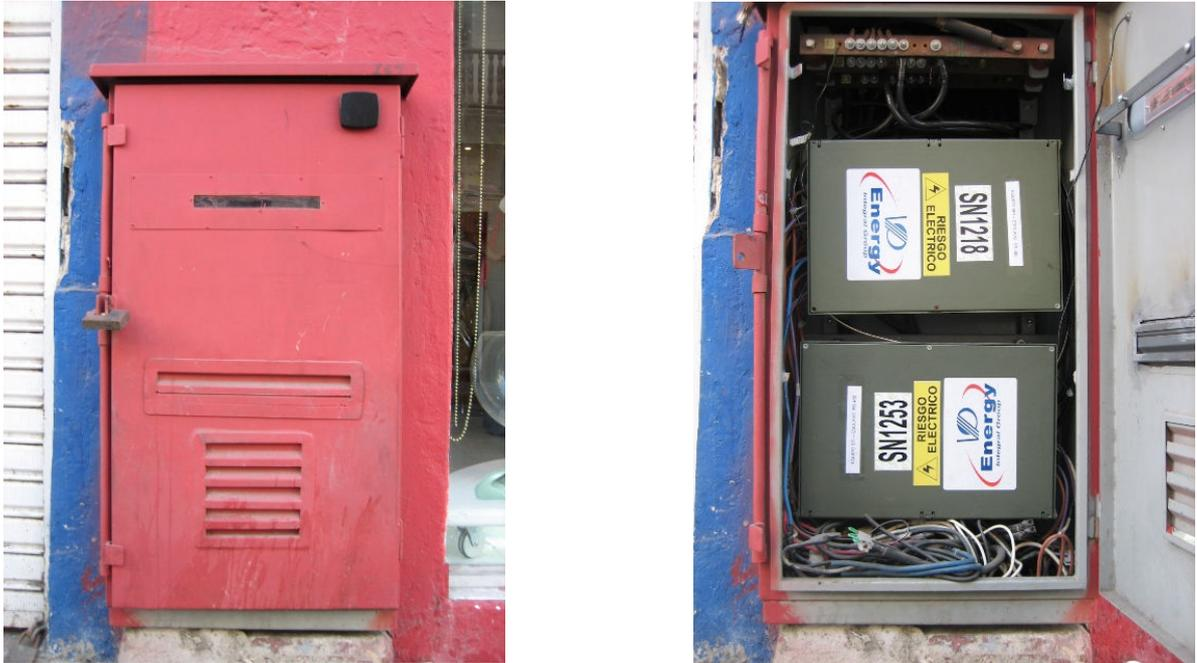
Figura 12. Equipos Esclavos Instalados en Gabinetes y Pertenecientes a la Subestación Badillo.
