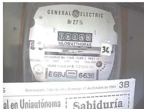
Figura 25. Medidor Detectado con devolución de 562 kWh.
