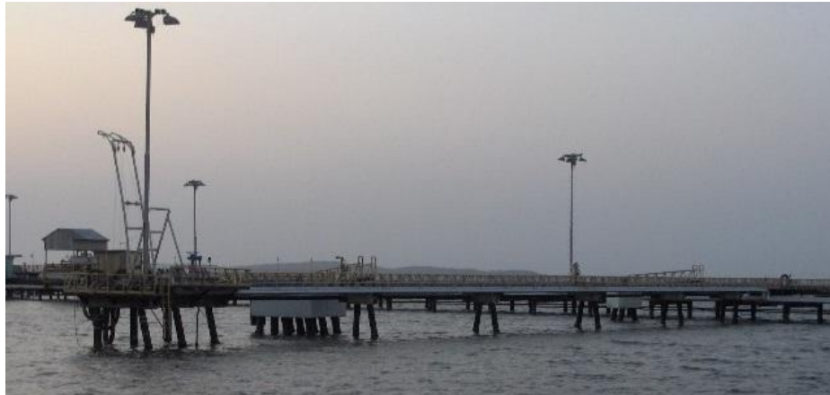
Ilustración 16 Terminal Marítimo GLP
