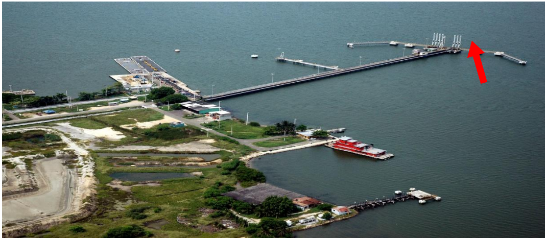
Ilustración 15 Terminal Marítimo de Refinería vista aérea
