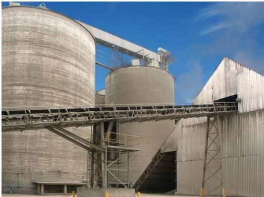
Figura 15. Silos de Almacenamiento de Cemento.
