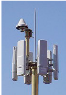
Figura No 30. Antena GPS ubicada con un emplazamiento de AP
