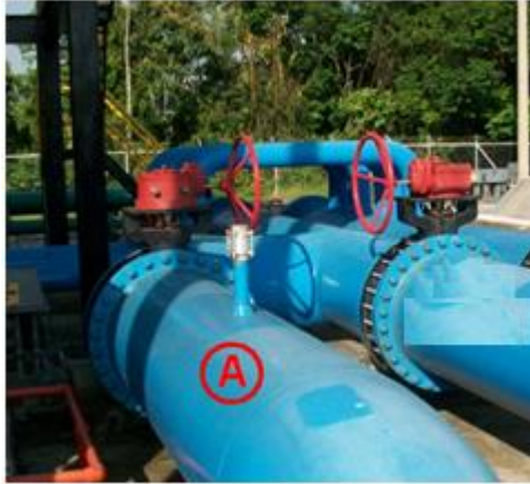
Figura 16. Línea descarga filtros EC2
