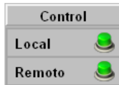
Figura 25: Indicadores de control de sistema de refrigeración
