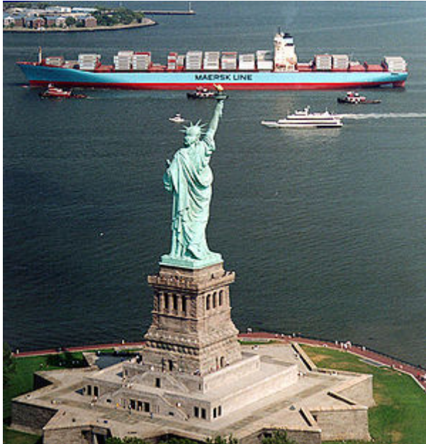
Figura 13. Embarcadero pasando delante de la Estatua de la Libertad.
