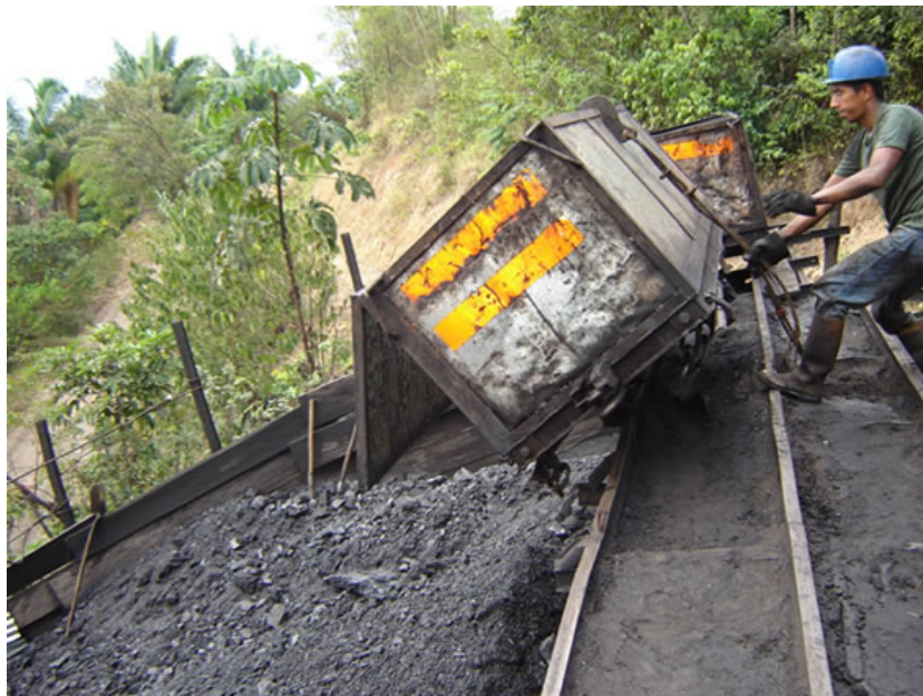
Figura 4. Acopio de carbón
