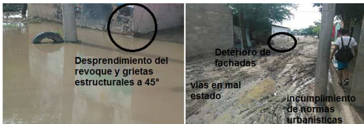
Figura 26. Afectaciones viales y de viviendas en época de invierno. Fuente: registro fotográfico tomado el 18 de abril de 2017
