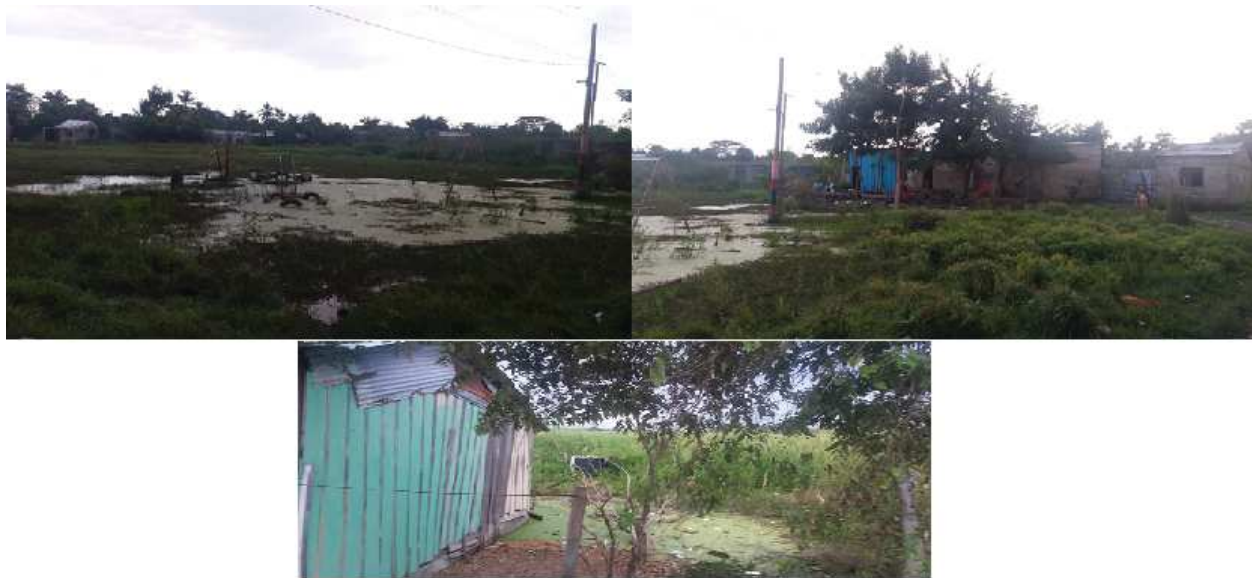
Figura 23. Sectores inundados por aguas de escorrentía en tiempo de verano. Fuente: registro fotográfico tomado el 25 de enero de 2017
