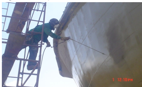
Figura 16. Aplicación de recubrimientos
