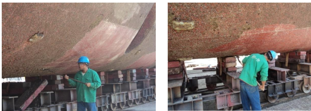
Imagen 6: Eliminación de residuos de la M/N en el proceso de rasqueteo
