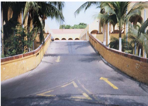
Figura 18. Vista de la rampa desde la primera planta
