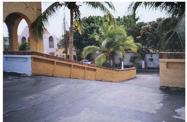
Figura 19. Vista de la rampa desde la segunda planta
