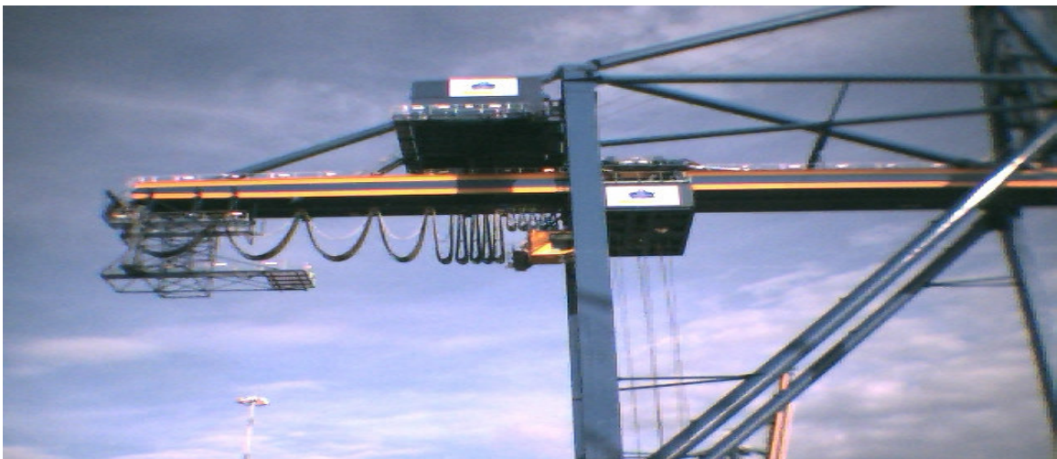
Figura 46. Cables de potencia del sistema de trolley.
