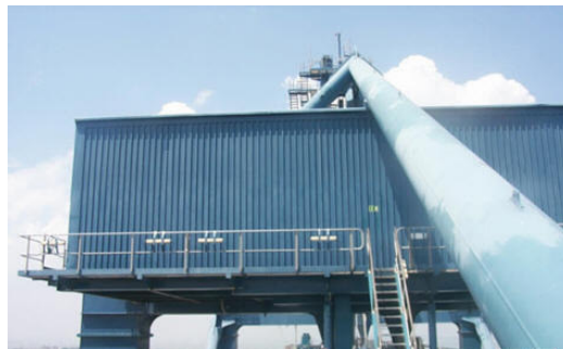
Figura 6. Cuarto de controles
