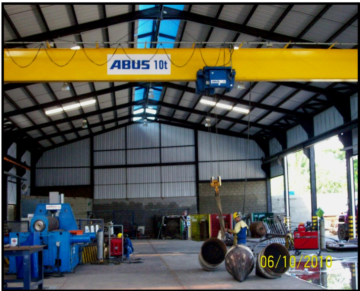
Figura 5. Puente Grúa Abus 10 Toneladas. Tomada del archivo fotográfico de Dinacol S.A.
