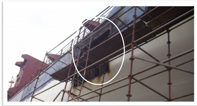
Figura 48. Cambio de lámina de casco de embarcación.
