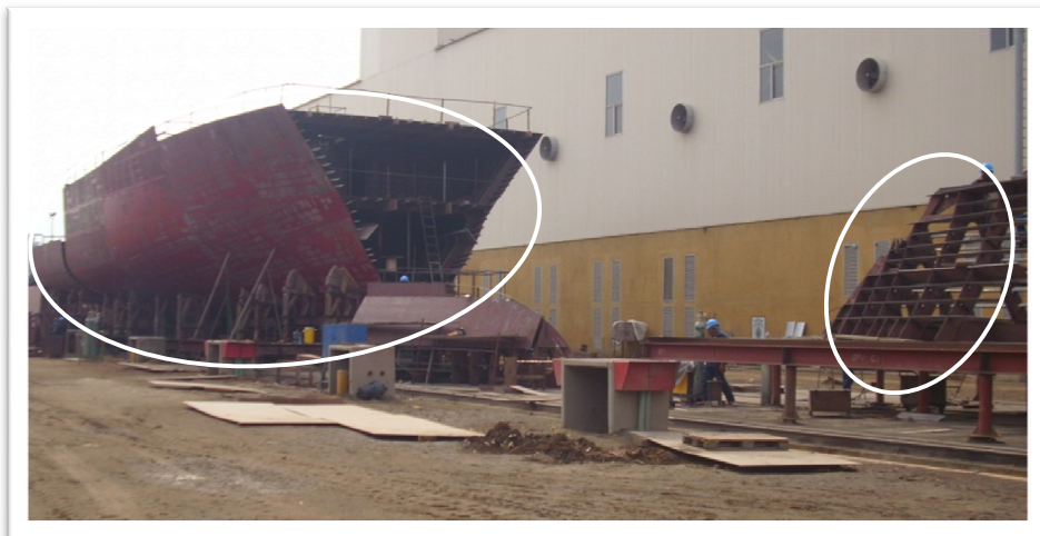
Figura 53. Construcción de embarcación tipo fragata.
