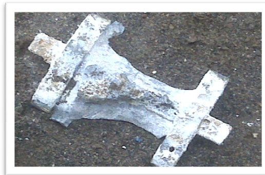
Figura 50. Protección catódica desinstalada.
