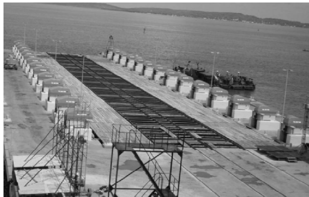
Figura 36. Puesta en seco de embarcación con tecnología de sincroelevador.
