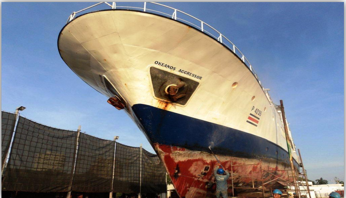
ANEXO D. Sandblasting
