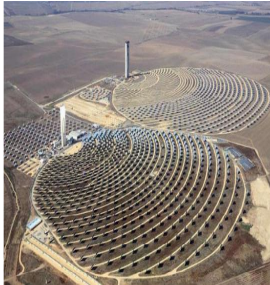
Ilustración 2.5 Plantas solares de torre.
