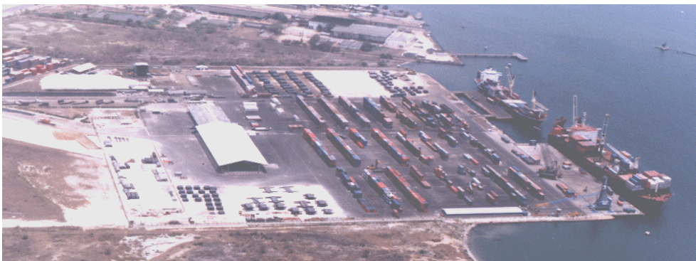
FIGURA 1. VISTA PANORAMICA CONTECAR
