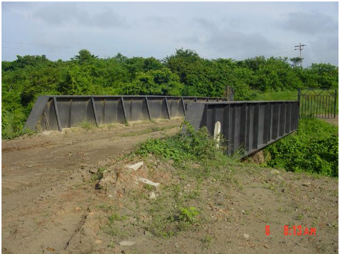
Puente Mina- Ladrillera.
