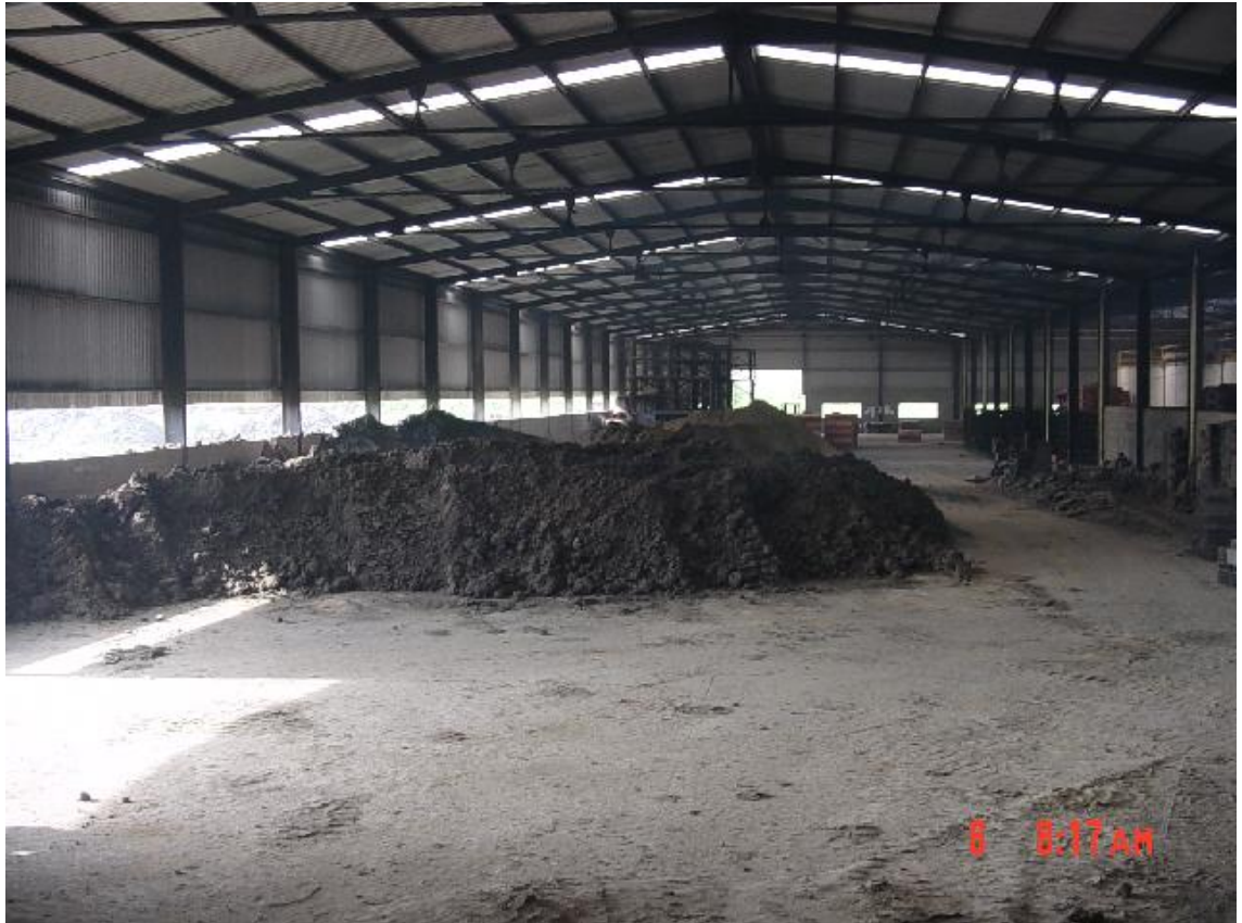
Bodega de Almacenamiento de Arcilla.
