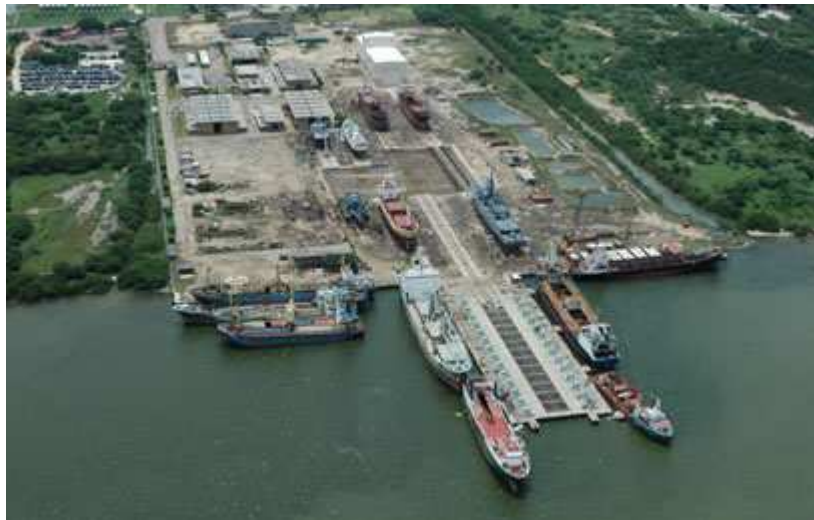
Figura 1. Vista aérea COTECMAR – Planta Mamonal
