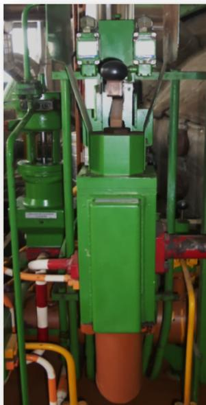
El dispositivo de cierre rápido se emplea para reducir rápidamente la presión del aceite en el circuito de cierre rápido. Si la presión que existe debajo del émbolo diferencial del dispositivo de cierre rápido SC14 K001 se reduce a menos de un valor ajustable, la fuerza del muelle empuja el émbolo hacia abajo, da paso al aceite rápido hacia el retorno y corta la afluencia del aceite de mando.
