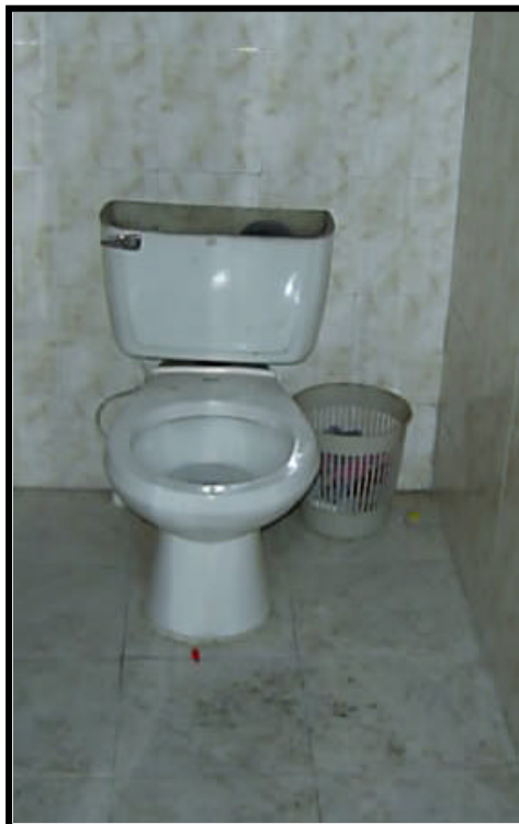
Figura 35. TMC Y CIA LTDA., Sanitario del baño en la zona de operaciones
