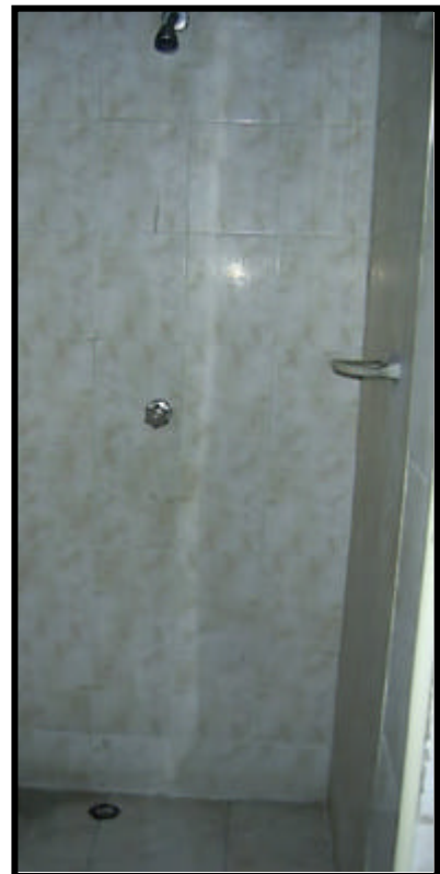
Figura 36. TMC Y CIA Ltda. Ducha del baño en la zona de operaciones
