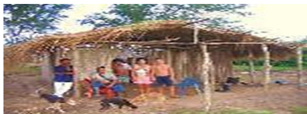
Imagen#7 construcción de los primeros ranchos.
