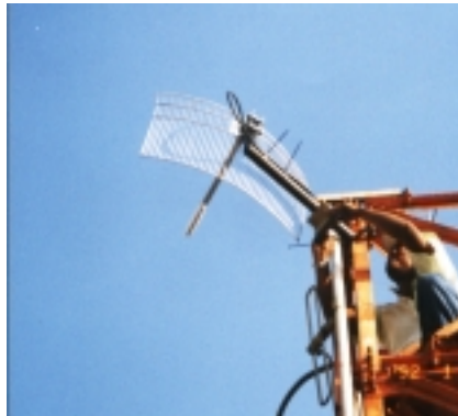
15. Instalación de la antena en la torre del Edificio Banco de Bogota
