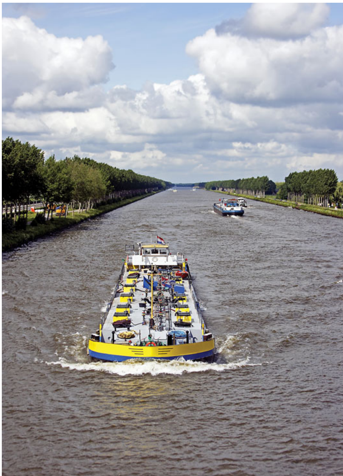
FIGURA 7. Canal Ámsterdam-Rin en Los Países Bajos
