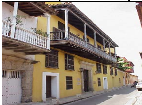
Figura 22. Casa del Marques de Valdehoyos.
