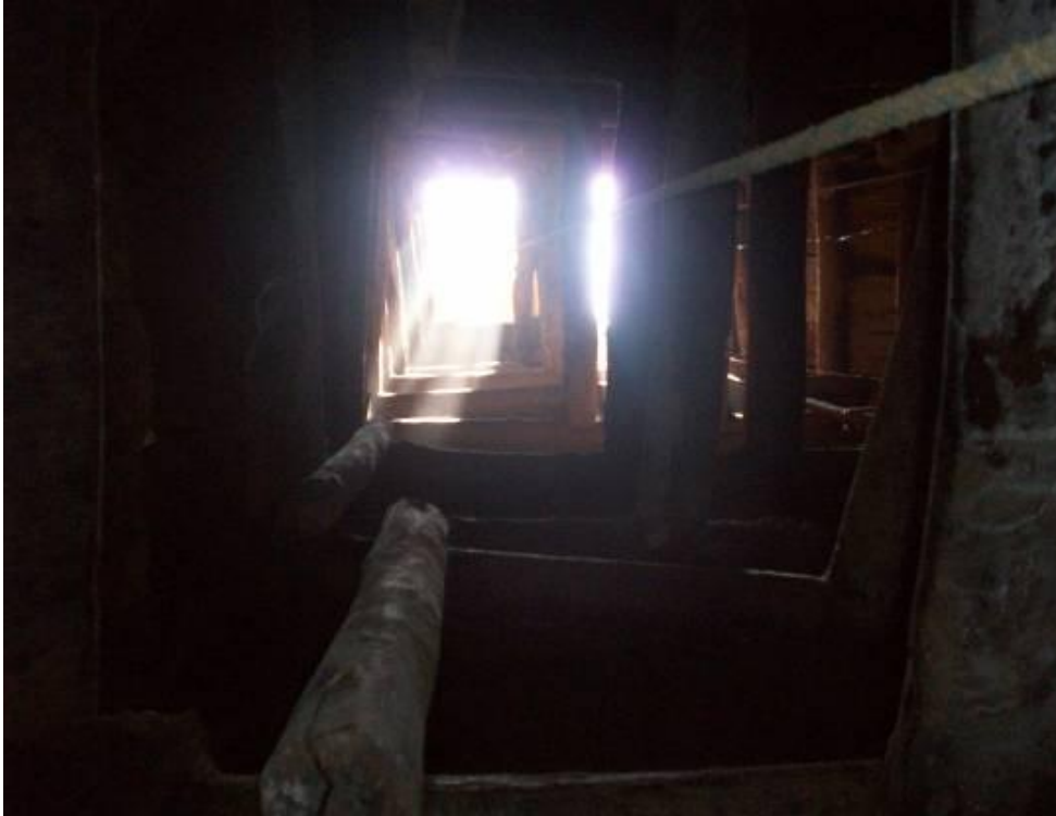
Fuente: fotografía zona el caño
