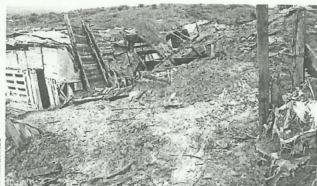
Según vecinos del lugar, varias viviendas del sector 3 de Junio del barrio Henequén se vieron afectadas con el deslizamiento de tierra en la zona.
