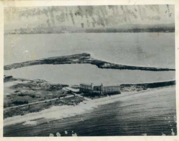
El Hotel Caribe recién construido en Bocagrande a finales de los años 1940, con el Laguito tras él, y al fondo la isla de Tierra Bomba (Fototeca Histórica Cartagena de Indias- Universidad Tecnológica de Bolívar).
