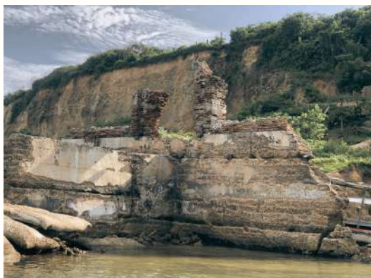
Los restos del aljibe construido por los españoles para almacenar agua dulce, en riesgo de desaparición por la erosión marina.
