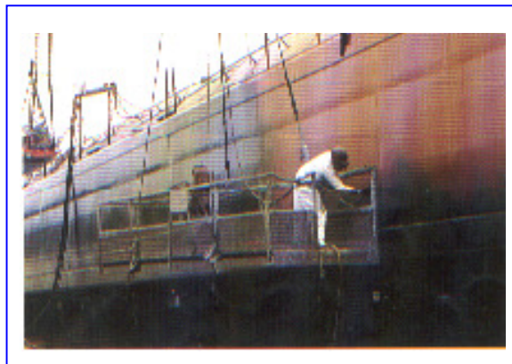
Figura 51. Aplicación de pintura de acabado
