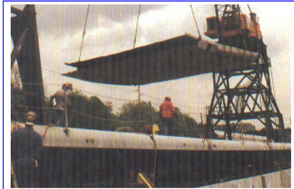
Figura 49 . Izada de blocks a la línea de ensamble
