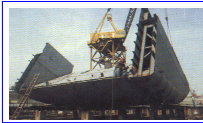
Figura 47. Subensamble del block de Proa
