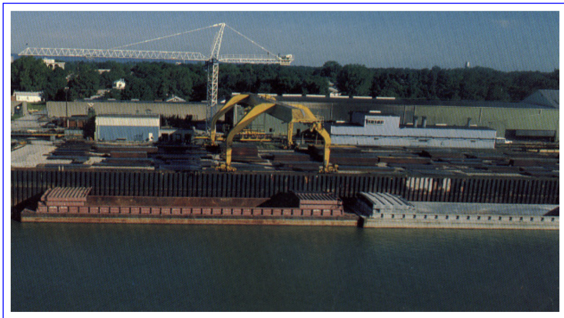
Figura 32. Grúa martillo del parque de láminas y perfiles
