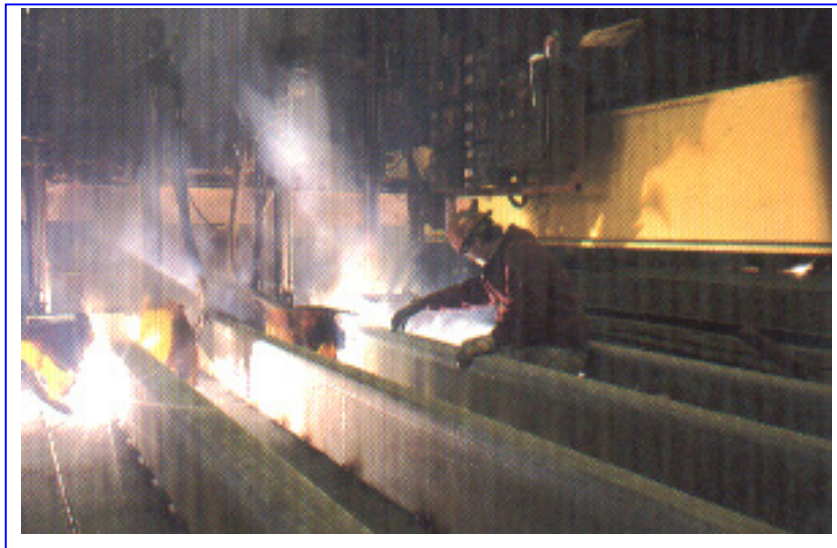
Figura 43. soldadura de perfiles MIG- MAG
