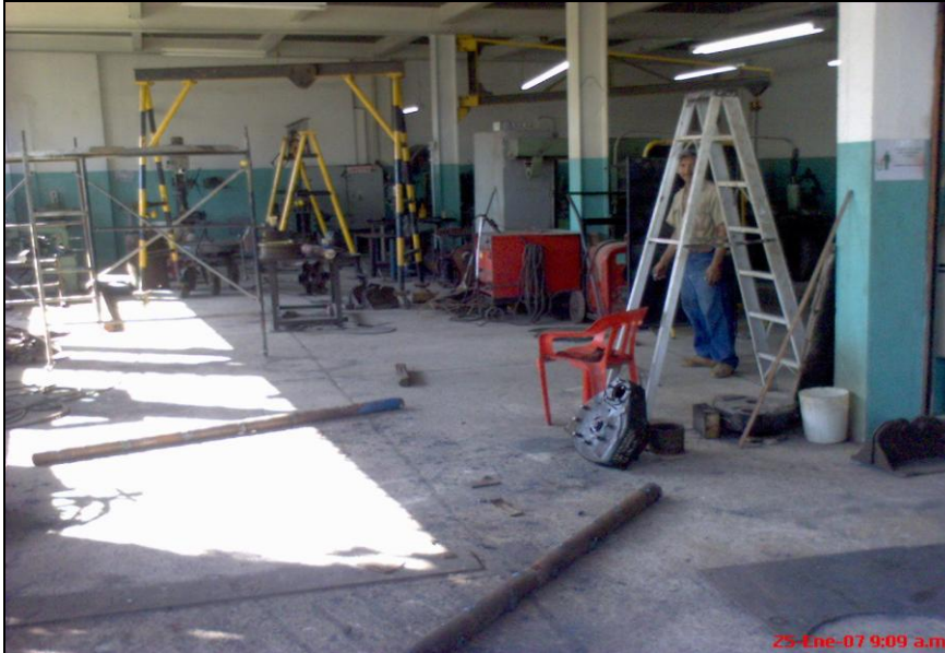
Ilustración 2 Servitec, pasillos del taller
