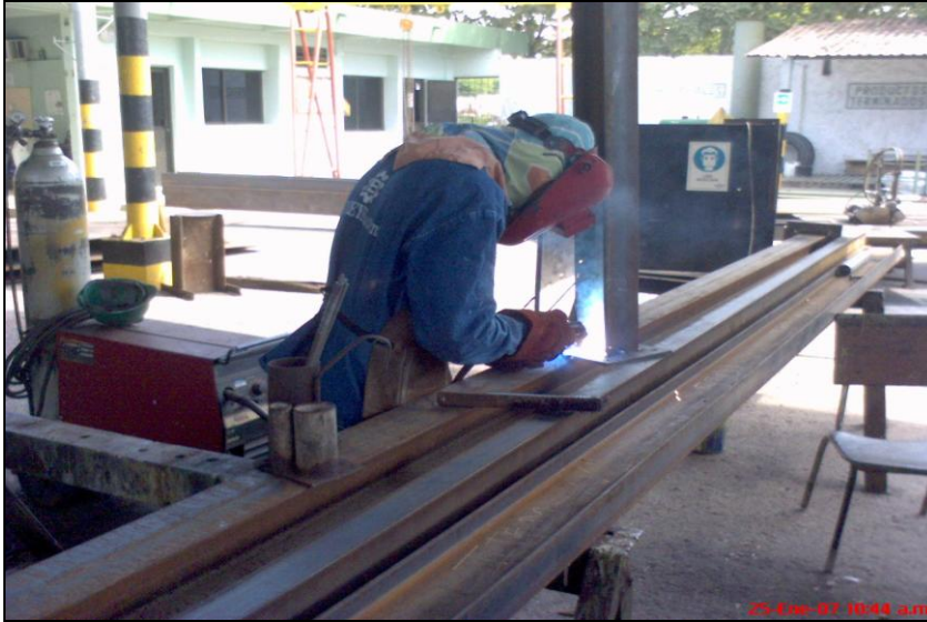
Ilustración 7 Bustos Reyes, Proceso de soldadura
