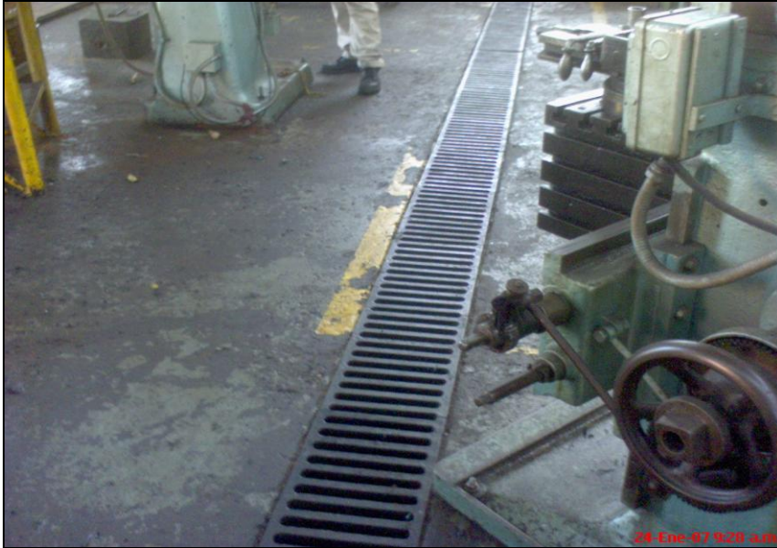
Ilustración 13 Ferretería Ignacio Sierra, Canal de desagüe
