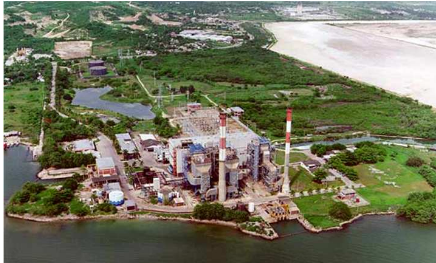
Ilustración 4. Instalación física de la central Cartagena.
