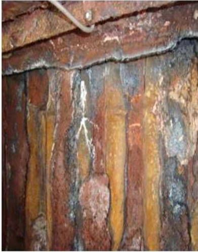
Ilustración 13. Pared 1 de la caldera fracturada.
