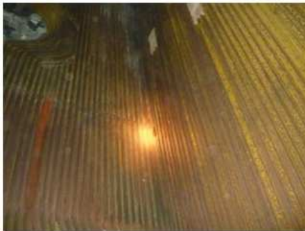
Ilustración 14. Fisura del tubo 110 de la pared 1 de la caldera.
