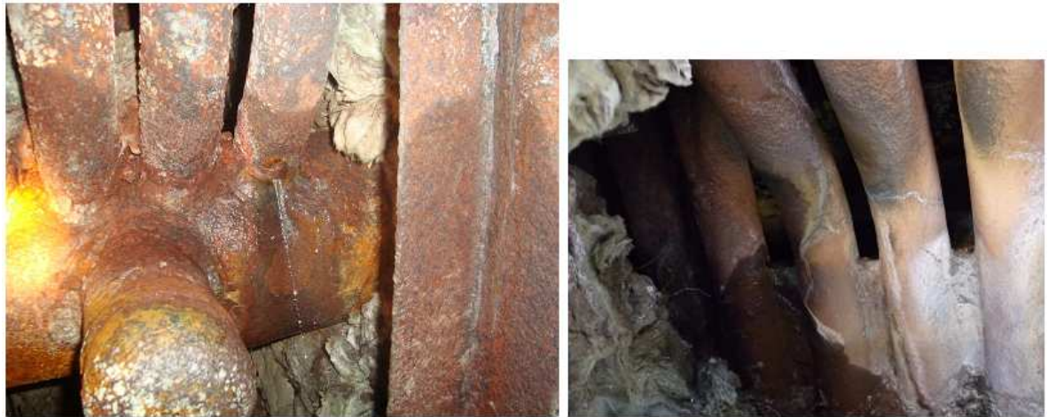
Ilustración 16. Fisura en la pared 4 de la caldera.
