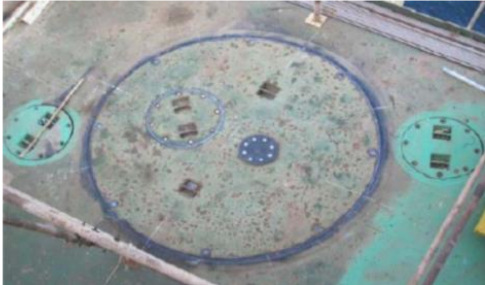
Figura 10. Recubrimiento instalado en soporte Caisson o Caisson Leg. (Rahman et al., 2014)
