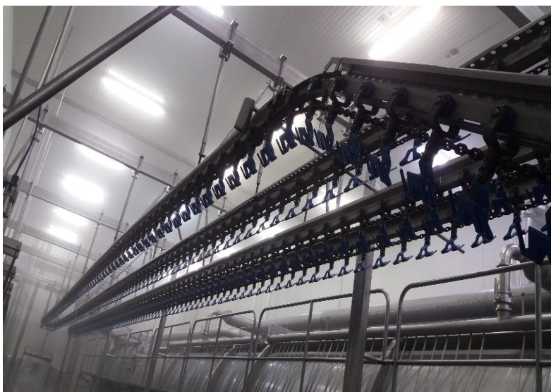
Ilustración 5. Línea de escurrido
