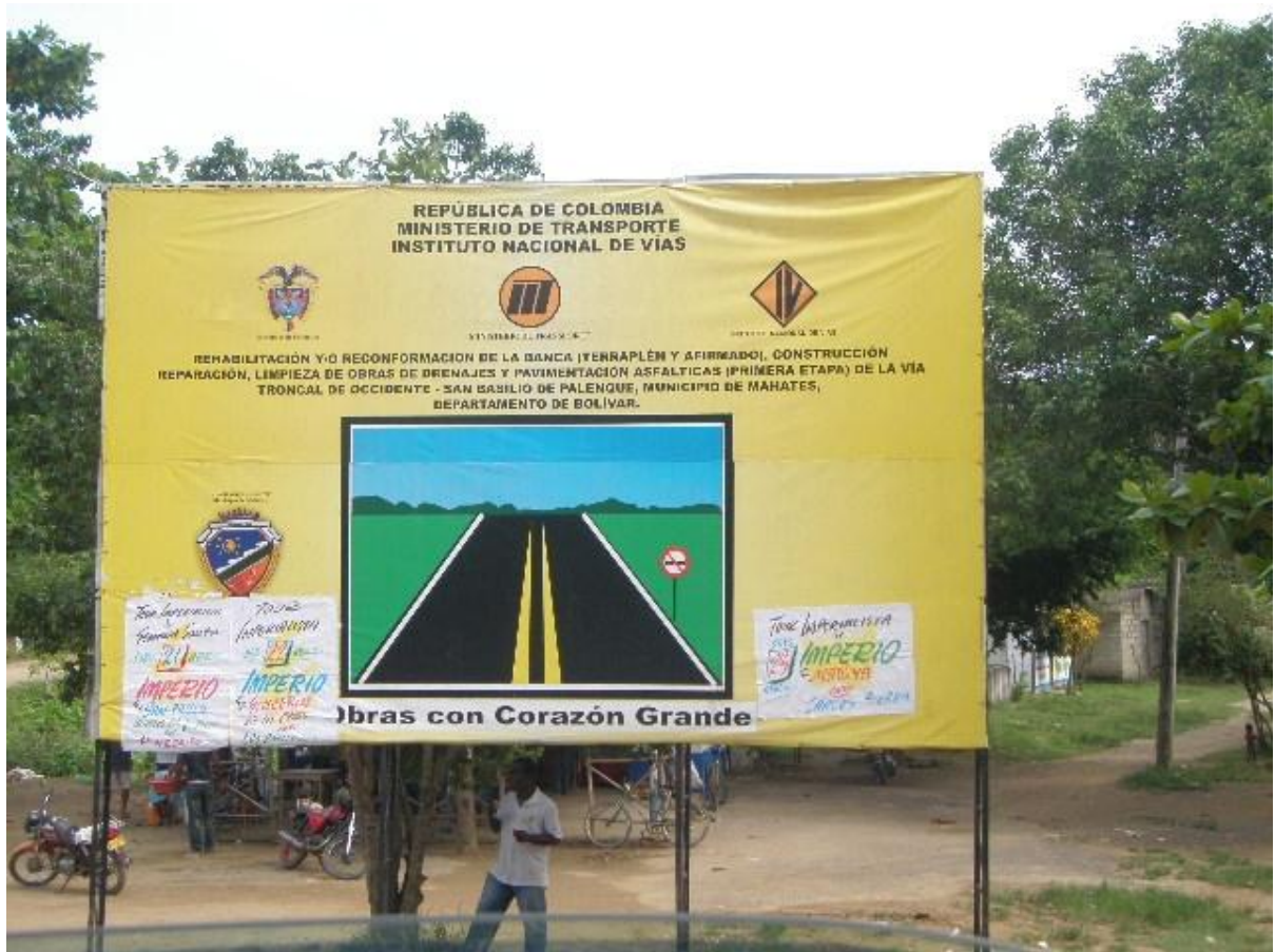
ENTRADA A SAN BASILIO DE PALENQUE Ministerio de Colombia Ministerio de Transporte Institución Nacional de Vías
