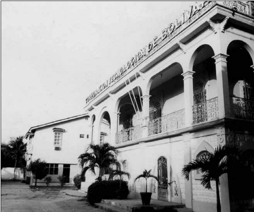
Fachada de la Casa Lemaitre, primera sede de la UTB.
