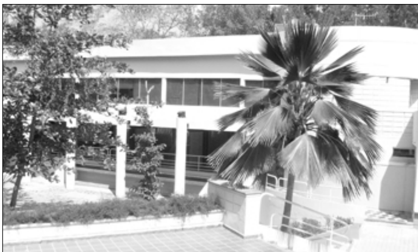
Fachada de la sala de profesores de la Facultad de Ingeniería.
