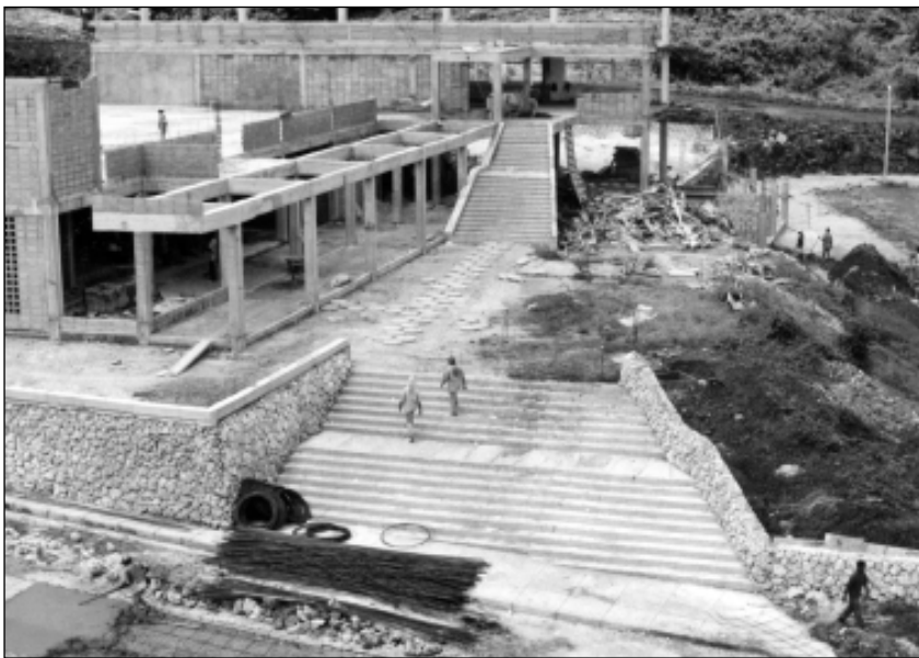
Construcción del edificio de Bienestar Universitario, Campus Tecnológico.
