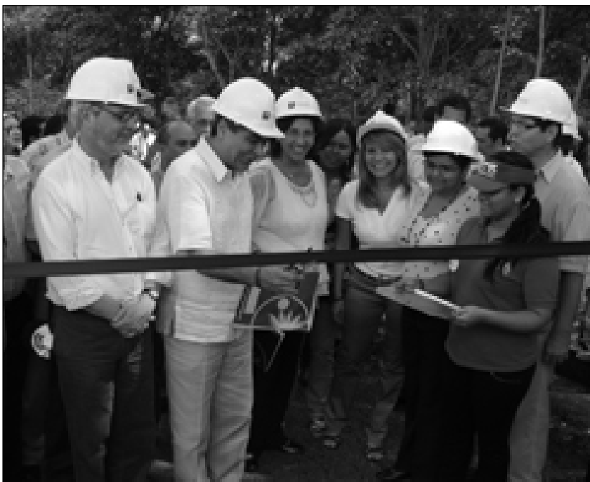
Se comienzan las obras de expansión del Plan Maestro de Infraestructura Física, 2009.
