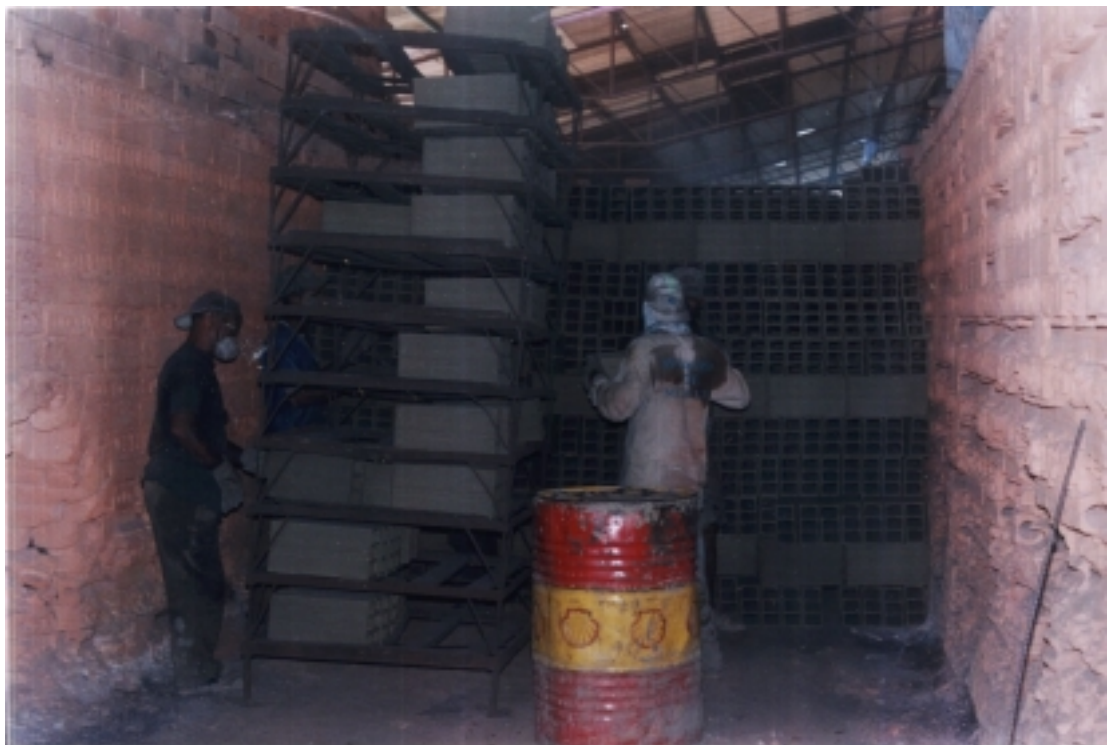
Figura 10. hornos de calentamiento para la cocción de ladrillos.
