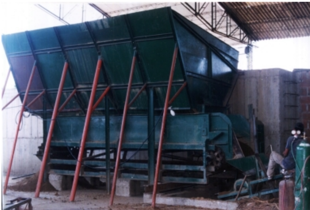
Figura 5. Preparación y Limpieza de las Arcillas en Tolva de Almacenamiento.
