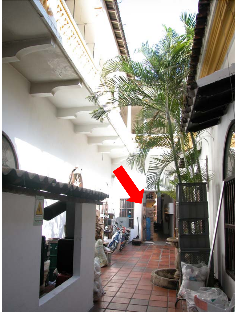
Zona de reciclaje. Al fondo, zona de almacenamiento temporal de materiales e insumos de la empresa Espitia Impresores.
